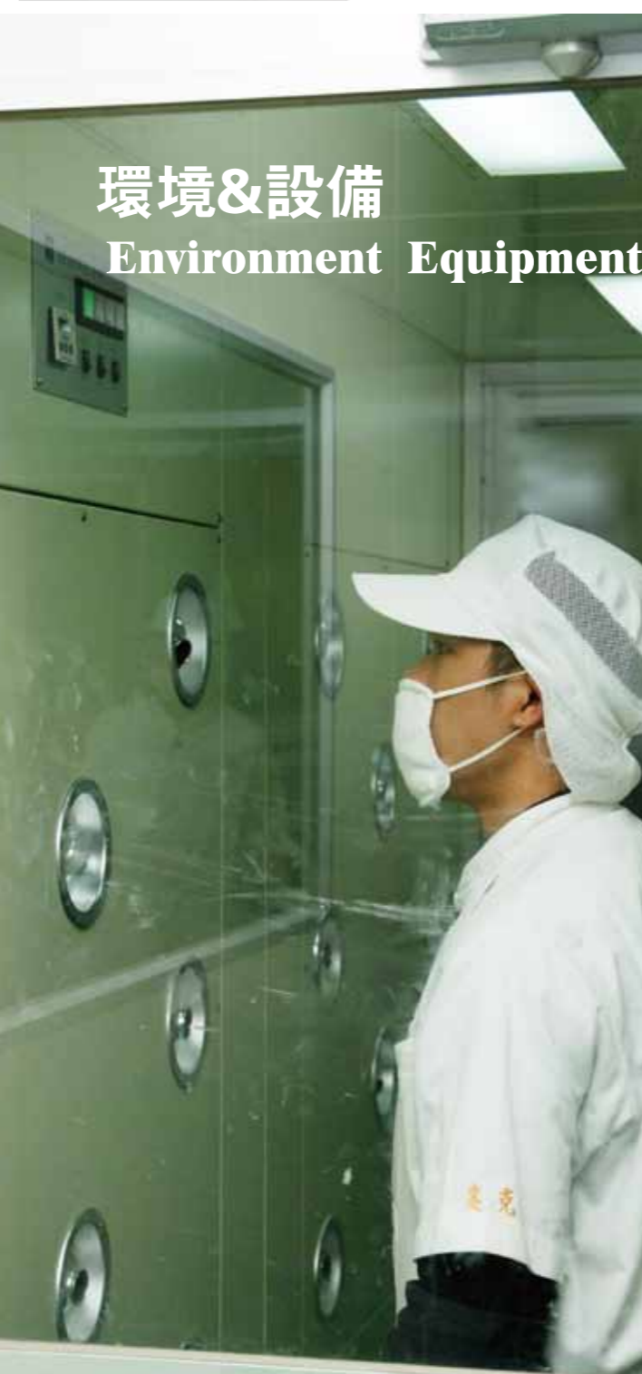
浴塵室 AIR SHOWER ROOM
